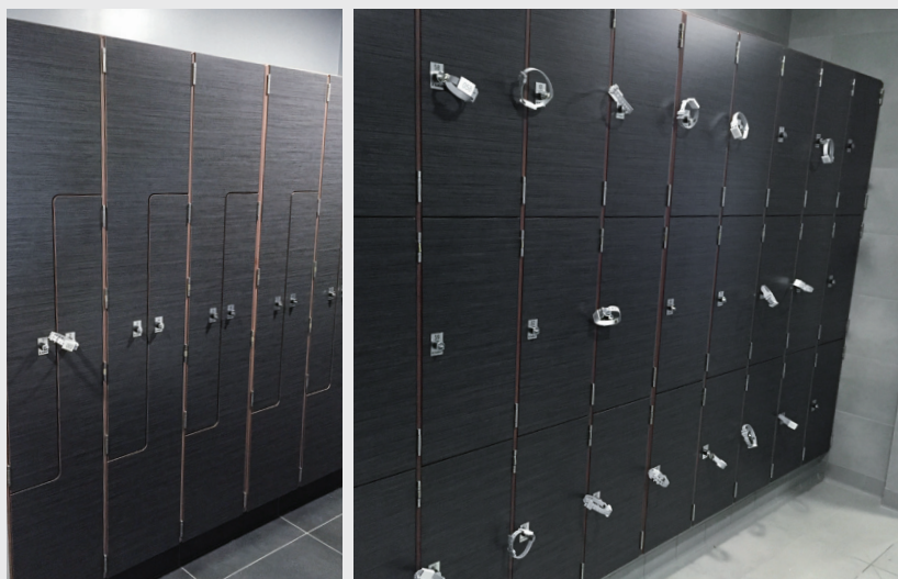
CENTRE DE FITNESS ET DE REMISE EN FORME À RENNES MONNAYEUR PIÈCE ET CARTE - 80 CASIERS
